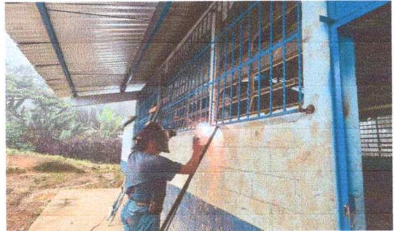
**Foto 6:** Se observa el trabajo de mano de obra calificada en la instalación de balcones nuevos para la protección de las ventanas.
