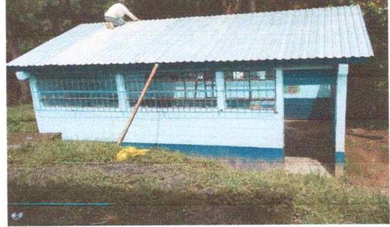
**Foto 2:** Instalación de láminas troqueladas calibre 26 en atención a las especificaciones establecidas.
