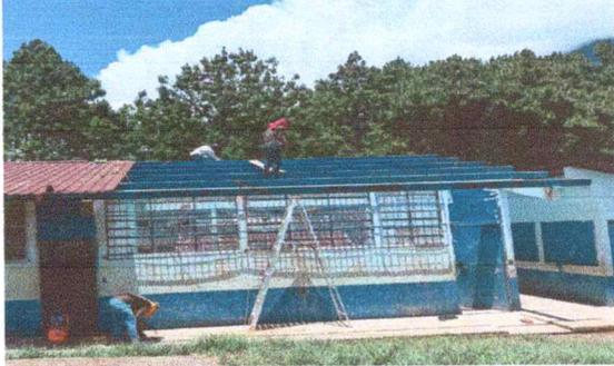
**Foto 1:** En la fotografía se aprecia el proceso de desinstalación de las láminas de zinc deterioradas para ser remplazadas laminas troqueladas calibre 26.
