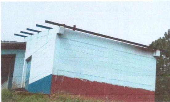
**Foto 3:** Desinstalación de láminas de zinc que corresponde al módulo de la cocina.
